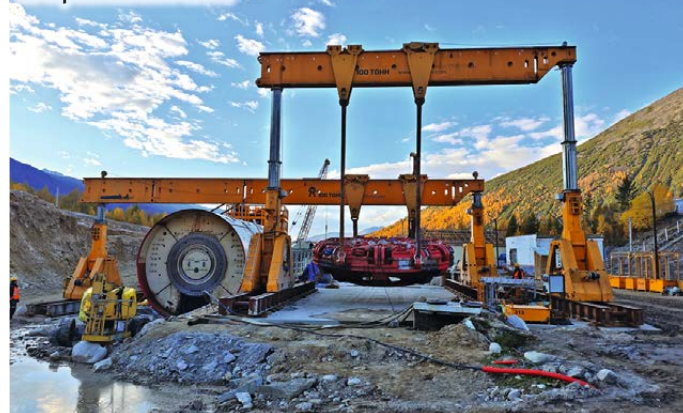
Установка ротора проходческого щита на строительстве БАМа
