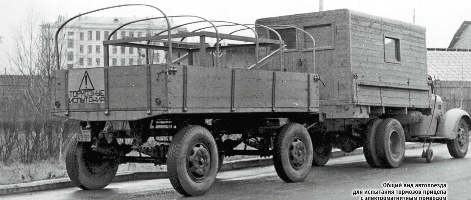
Общий вид автопоезда для испытания тормозов прицепа с электромагнитным приводом
