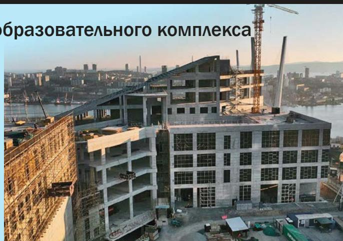
менного теплового контура здания для проведения внутренних работ. Кроме того, в зоне учебной сцены филиала РГИСИ приступили к монтажу металлических ферм перекрытия. Это строительная конструкция, которая будет перекрывать большой пролет и обеспечит прочный каркас для крыши», – рассказал генеральный директор СТГ-Восток Е. Кошелев.
